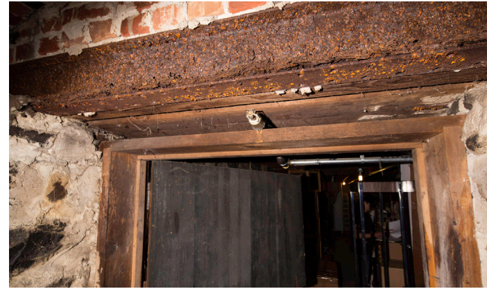
4554 - Beam Above Hatch Door
